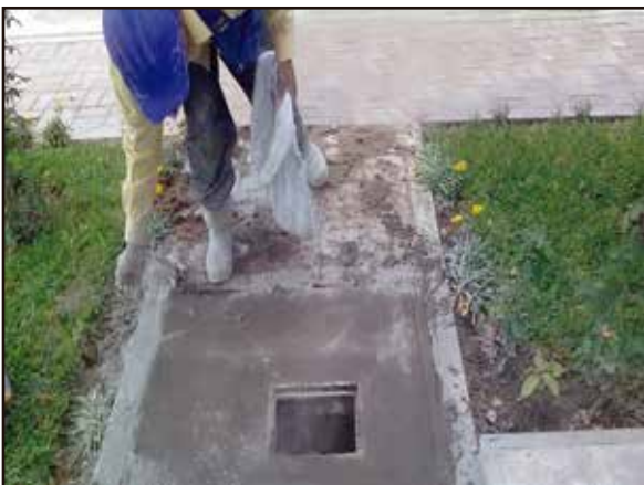
Instalación concluida y reposición de pavimento
