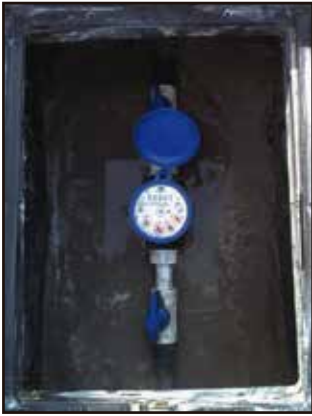
Instalación de medidor con batería estándar
