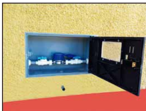
Instalación de medidor empotrado en pared
