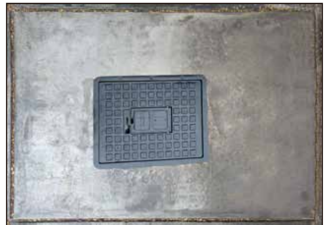
Instalación concluida de marco y tapa
