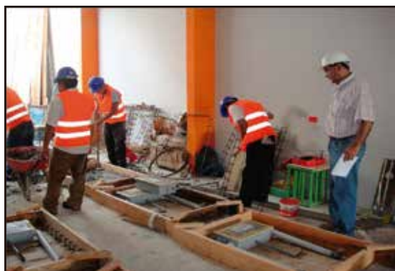
Fabricación de muretes
