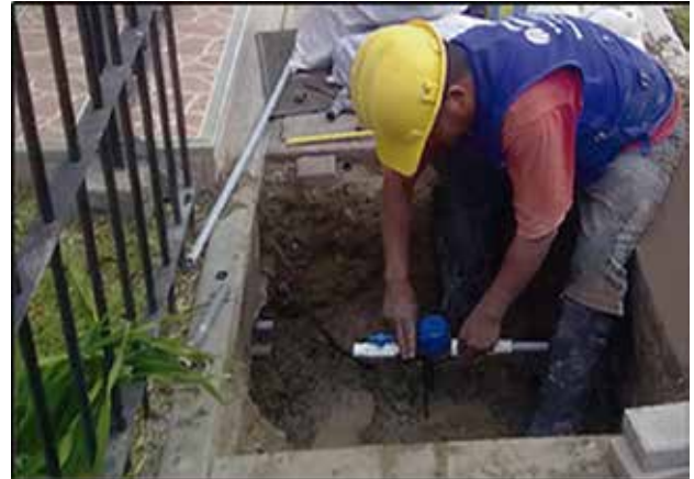
Instalación de batería de medidor
