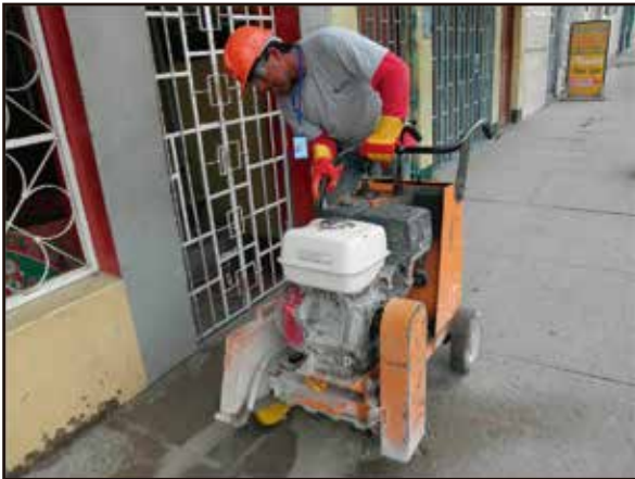
Corte en vereda para instalación de medidor
