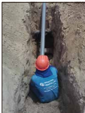
Reparación y cambio de tubos de conexiones
