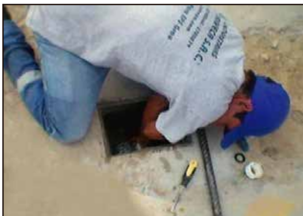
Intervención del medidor
