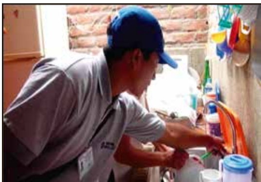
Inspección de fuga de agua en cocina
