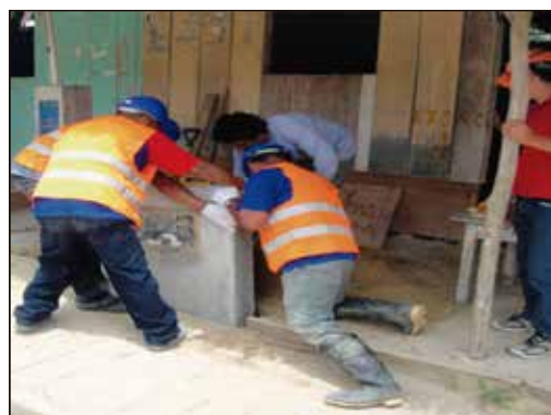
Instalación de murete
