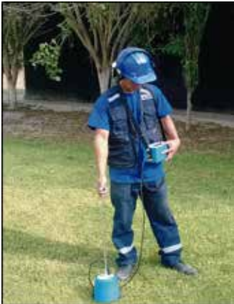
Detección de conexión clandestina con geófono
